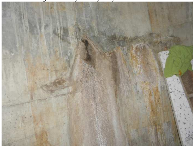
Foto 22 Fragment ściany komory z wyciekami – do uszczelnienia
