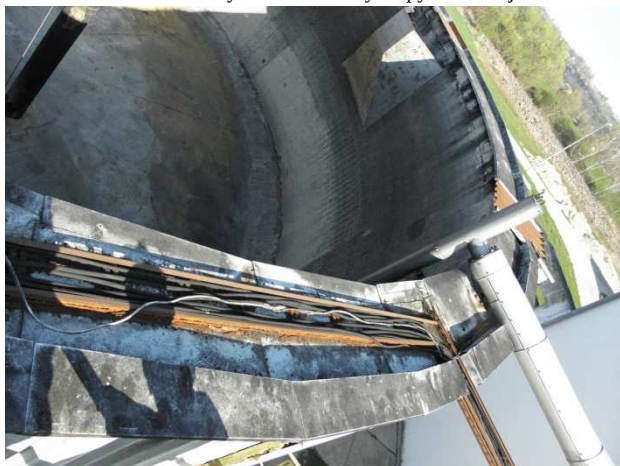
Foto 7 Widok fragmentu ścian zbiornika – zbrojenie bez otuliny!!
