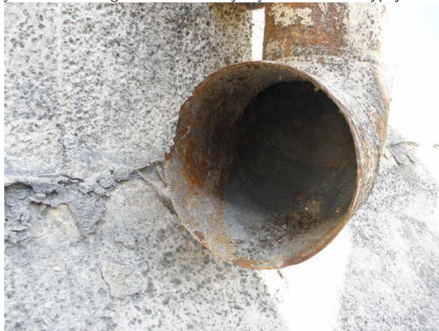
Foto 20 „przeżarta rura leja zlewowego w dnie zbiornika – do wzmocnienia
