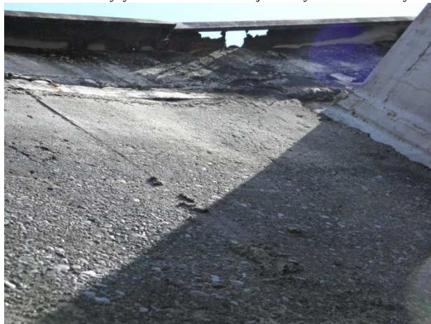
Foto 8 Odkryte zbrojenie wewnętrznej siatki ściany zbiornika !
