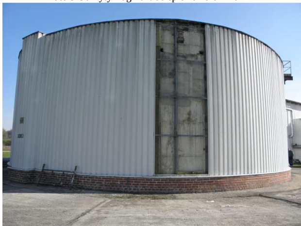
Foto 3 Odkryty fragment ocieplenia zbiornika
