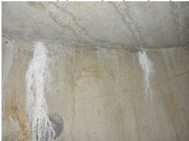
Foto 25 Fragment uszkodzonej ściany zbiornika z kieszenią przelewu
