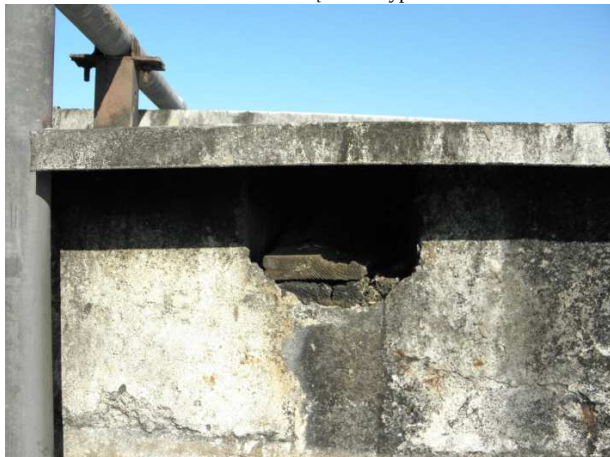
Foto 13 Widok szczeliny pomiędzy ścianą a nadlewką – wieńcem
