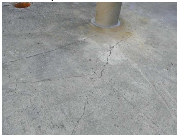
Foto 16 Fragment spękanego dna zbiornika – do iniekcji konstrukcyjnej żywicznej
