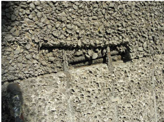
Foto 19 Zniszczona powłoka antykorozyjna słupa
