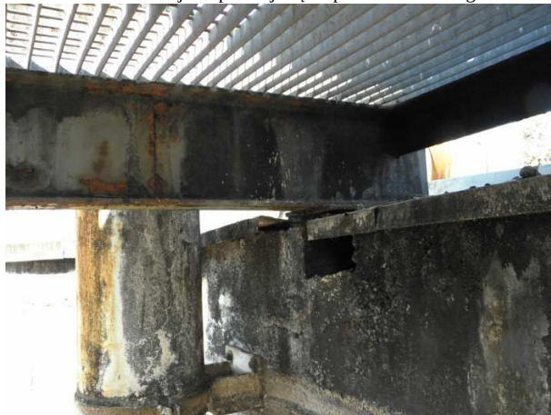
Foto 14 Wżery w betonie do zbrojenia ściany zbiornika.
