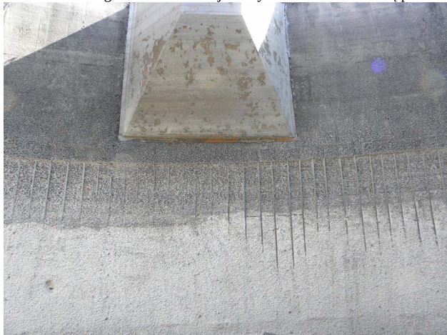
Foto 27 Nieuszczelna dylatacja w kanale obsługi technologicznej
