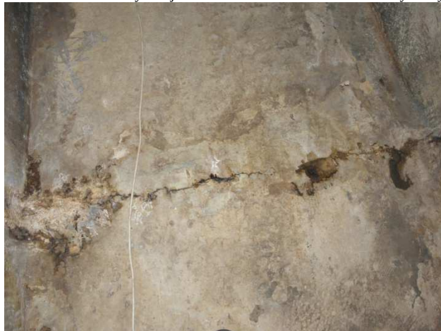
Foto 28 Inna dylatacja z uszkodzeniem – nieuszczelna do wymiany
