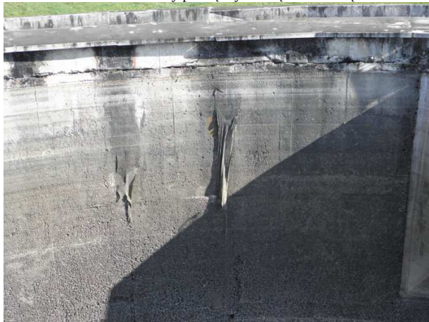
Foto 15 Widok fragmentów uszkodzonego betonu w ścianie zbiornika
