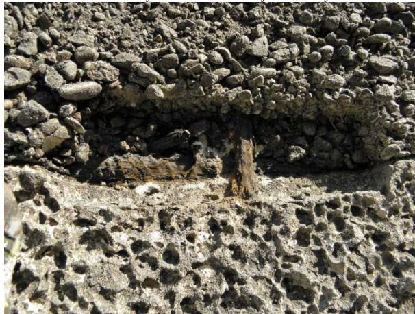
Foto 16 Fragment spękanego dna zbiornika – do iniekcji konstrukcyjnej żywicznej
