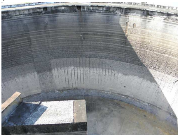
Foto 15 Widok fragmentów uszkodzonego betonu w ścianie zbiornika
