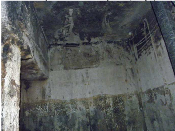
Foto 9 Widok fragmentu zniszczonego betonu z izolacją epoksydową
