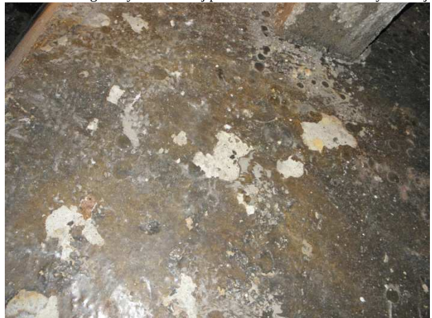
Foto 14 Fragmenty zniszczonej powłoki i betonu dna komory mokrej.
