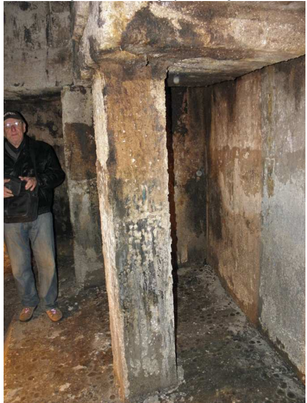
Foto 14 Fragmenty zniszczonej powłoki i betonu dna komory mokrej.
