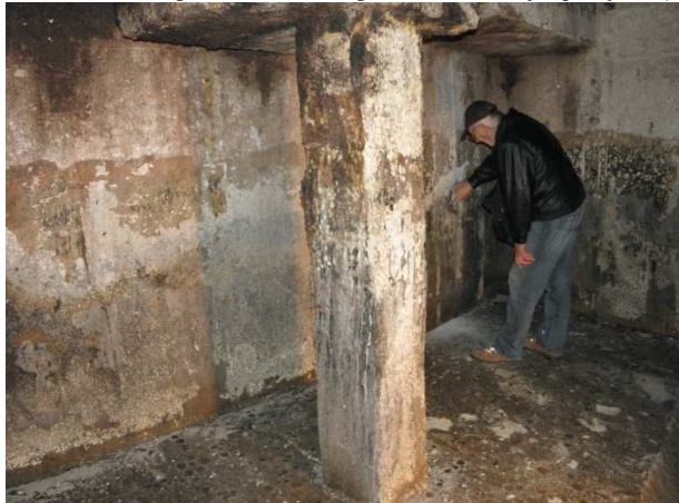
Foto 9 Widok fragmentu zniszczonego betonu z izolacją epoksydową
