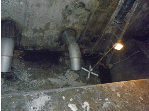
Foto 10 Silna korozja chemiczna powłoki epoksydowej i betonu
