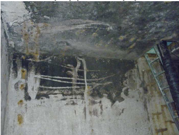
Foto 13 Widok korozji stropu pod szafami elektrycznymi NN
