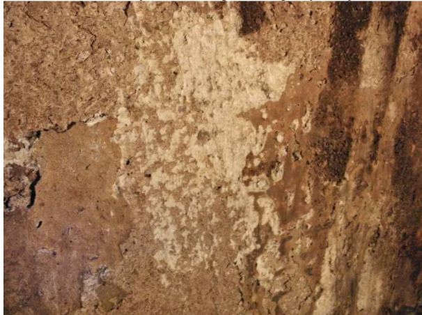
Foto 10 Silna korozja chemiczna powłoki epoksydowej i betonu
