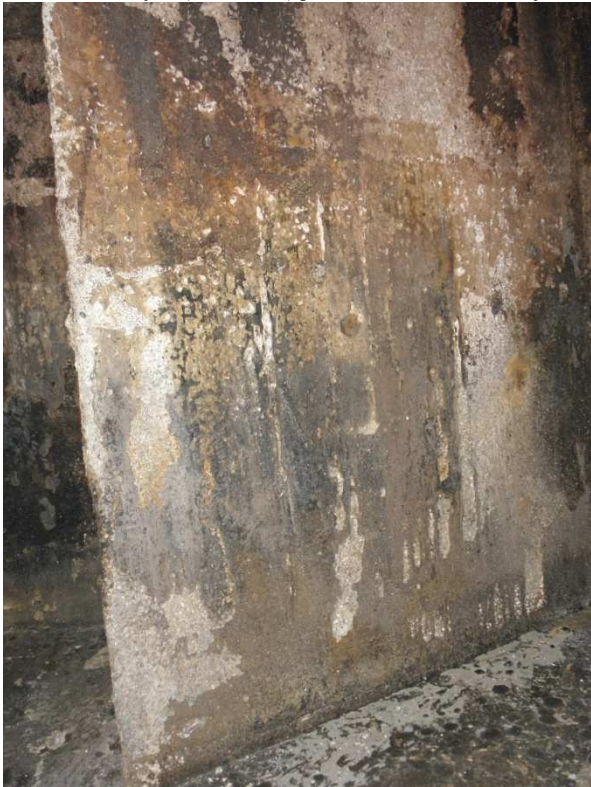
Foto 13 Widok korozji stropu pod szafami elektrycznymi NN
